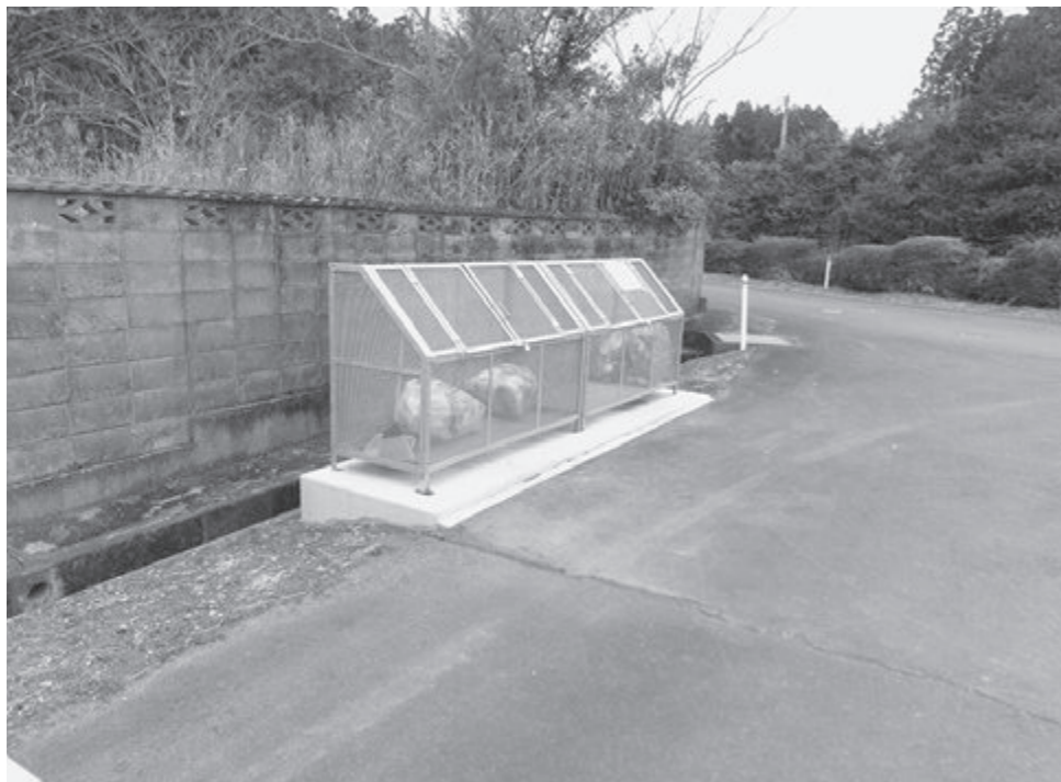
▲新設されたゴミ収集所（杉目地区）
