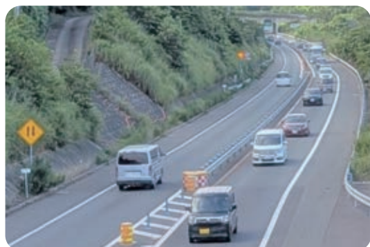
4車線化が待たれる常磐自動車道
