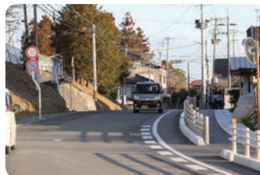
完成した通学路の歩道
