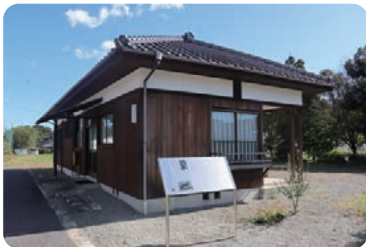
くるめがすりの家
