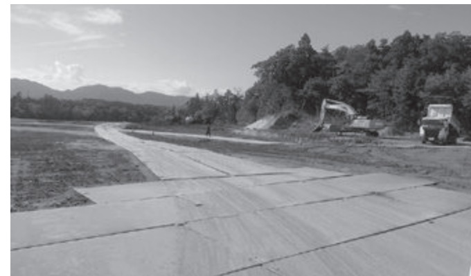
▲残土の搬入が進んでいる埋立て地
