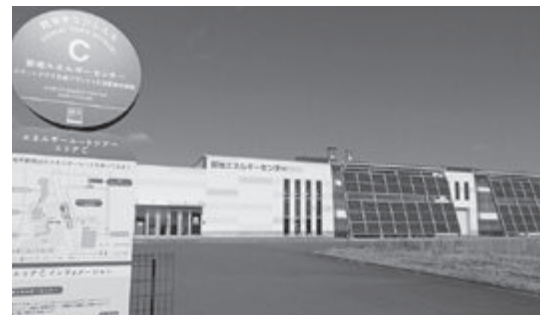
▲駅周辺施設へ電気と熱を供給
