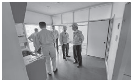
▲設備の老朽化が進む小川町営住宅
