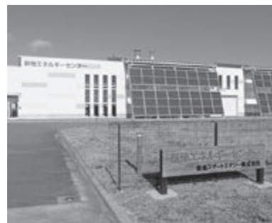
▲新地エネルギーセンター
