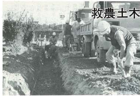
▲工事の始まった救農土木事業
