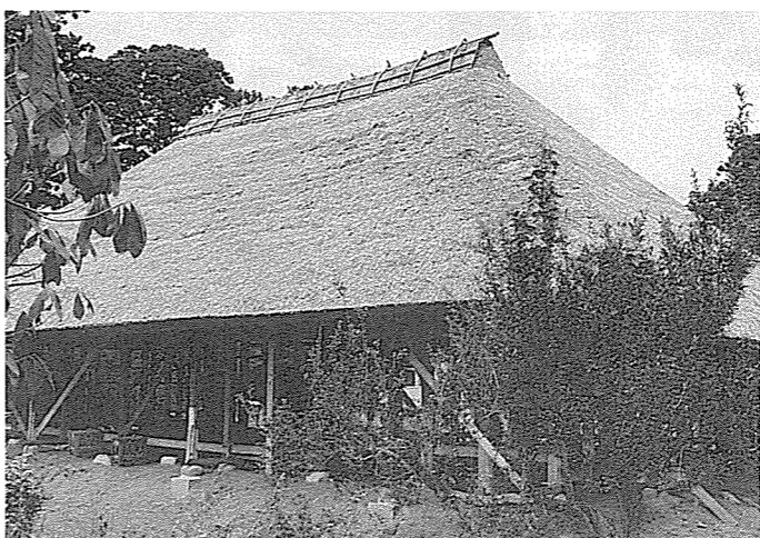
かやぶき屋根をふき替えし、復元工事中の観海堂
